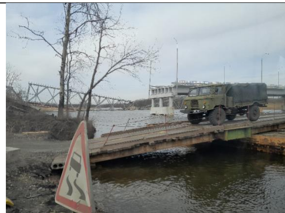
Verwoeste spoor- en wegbruggen over Severo-Donetsk kanaal.
